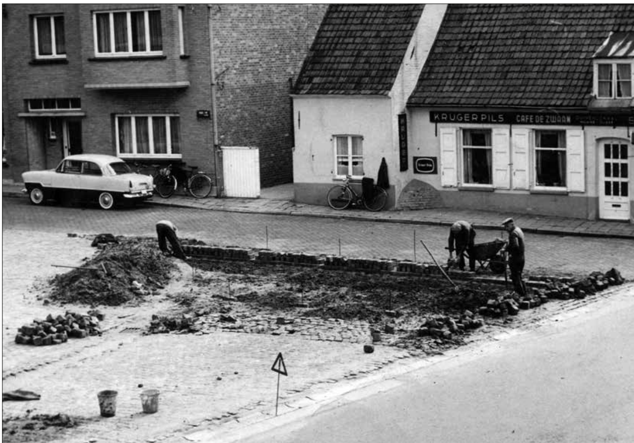
▲ Begin de jaren 1960. Marcel Focquaert is met zijn ploeg aan het kasseien op De Plaats.
