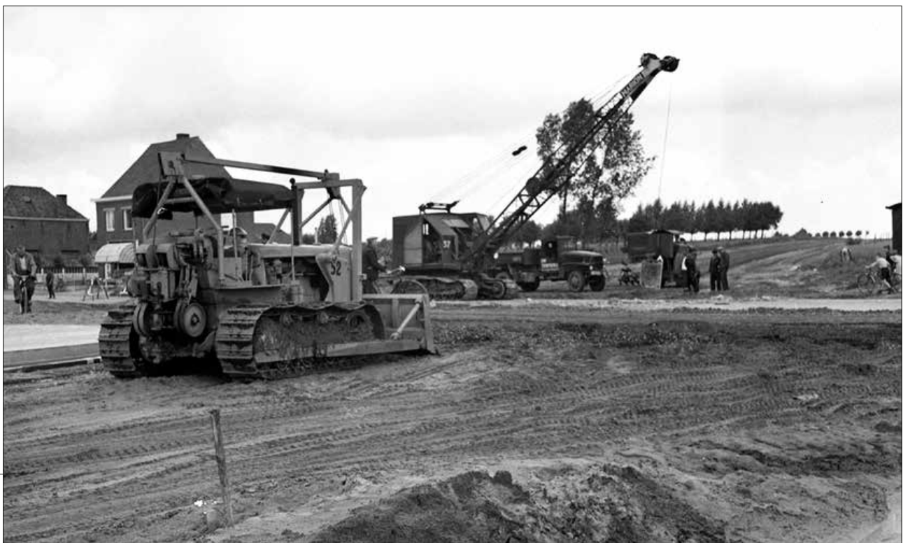
▼ Voor de Knokseweg moeten dertig huizen weg. De afstand Aalter-Maldegem wordt drie kilometer korter.
